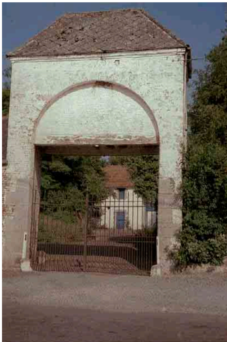
26. Porche d'entrée de ferme, n° 6 rue du Tambourin.
